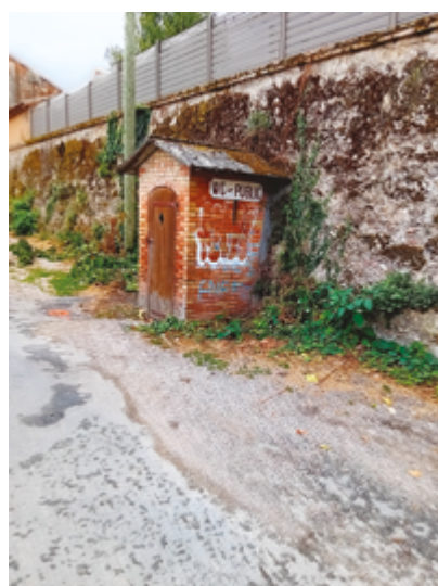
+ LE WC OBSOLÈTE, DÉGRADÉ ET SOURCE DE DÉPENSE D'EAU A ÉTÉ RETIRÉ
