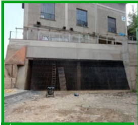
DÉGRILLEUR ET PLAN DE GRILLES ACTUELS
