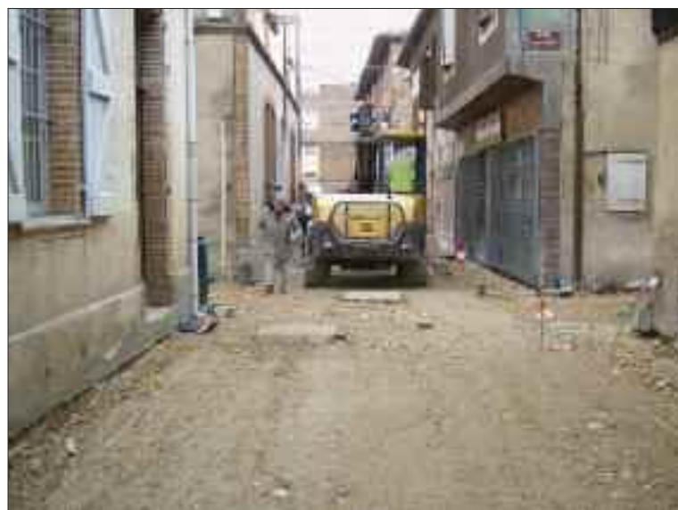
Chantier rue Porte Peyrole
